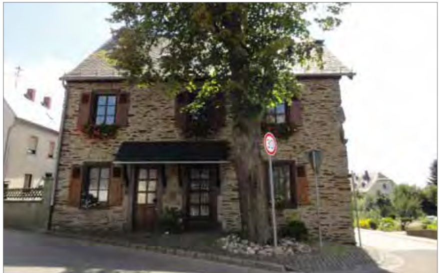
Abb. 160: Typische Bruchsteinbauweise Ortskern Kaifenheim Foto: Kernplan
