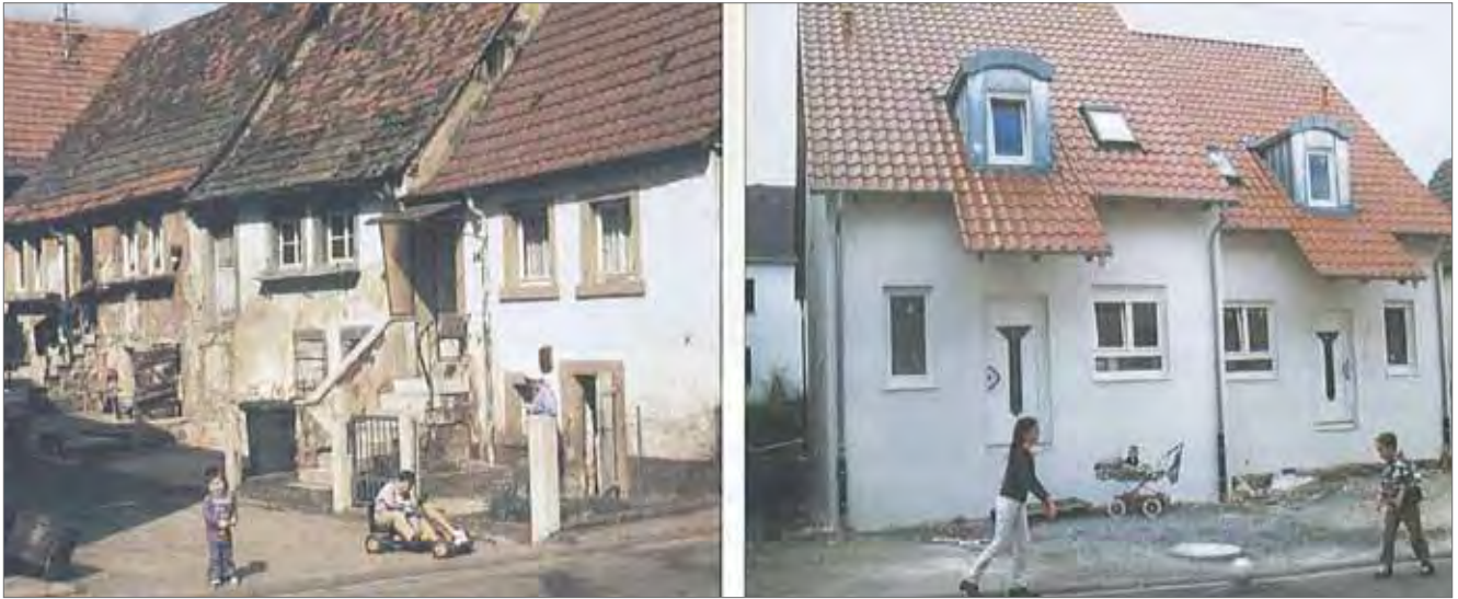
Abb. 152: Beispiel einer Dorfumbaumaßnahme: Abriss desolater Altbausubstanz für innerörtliche Neubaumaßnahmen, Bsp. Gemeinde Sulzfeld Baden-Württemberg Quelle: Ministerium für Ernährung und Ländlicher Raum Baden-Württemberg: 50 Jahre Entwicklung ländlicher Gemeinden in Baden-Württemberg
